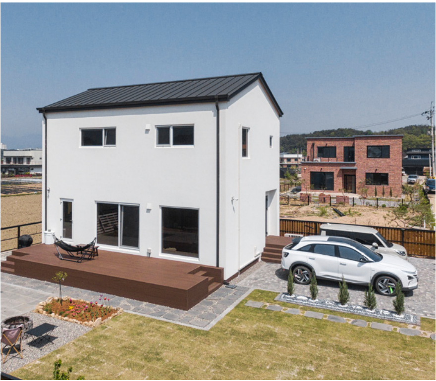
Projeto de construção em madeira concluído na Coreia do Sul
