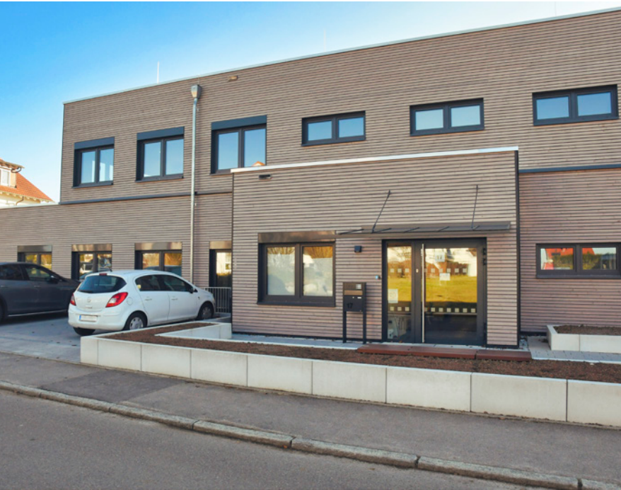
A Creche Kindertagesstätte Wittum 1 em Reutlingen, construída com módulos de construção em madeira
