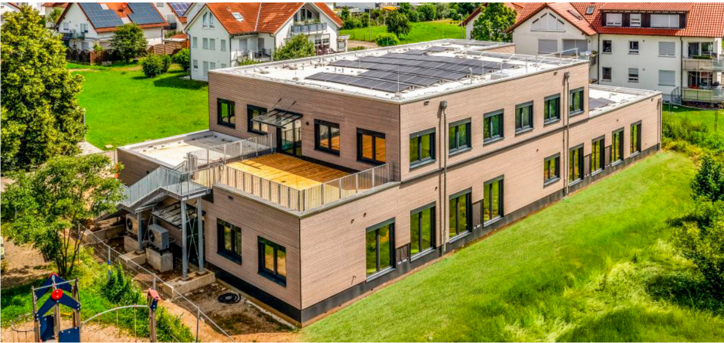
A Creche Kindertagesstätte Wittum 1 em Reutlingen, construída com módulos de construção em madeira
