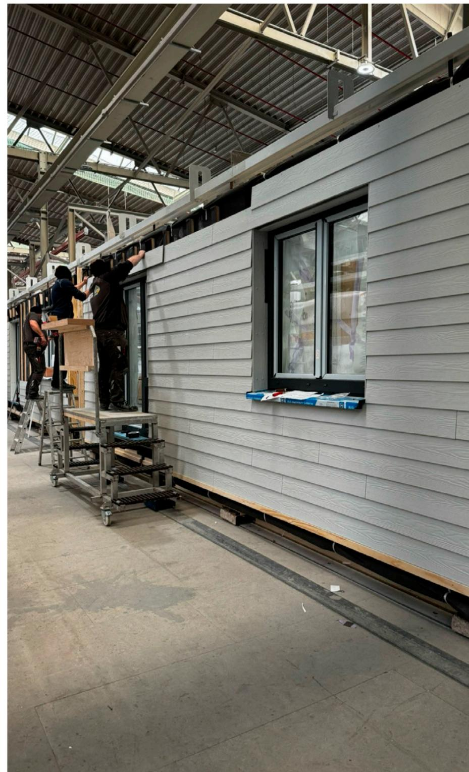
Fassadenelement für die serielle Sanierung in der Vorfertigung
