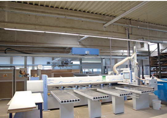
Die an das neue Lager angeschlossene Holzma-Säge ist bereits seit 2011 in Betrieb
